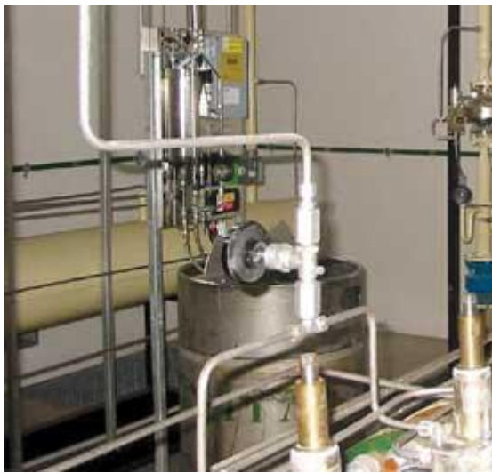
Obr.3.1 Príklad využitia vstrekovacieho odorizačného zariadenia na STL výstupe
